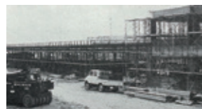
73 工場建設中の写真。フィルタ、メータの製造工場としてスタート
